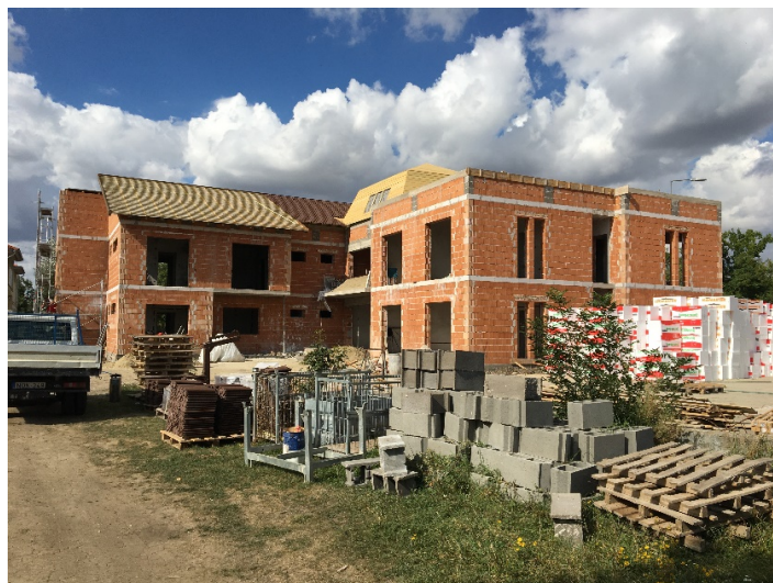
A képen a munkásszálló építése zajlik
